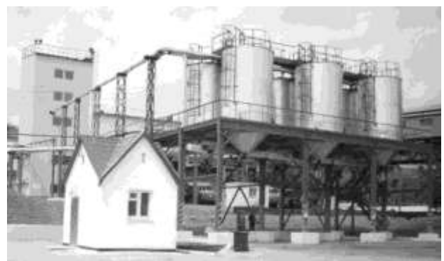
Рис. 9 Зливний трубопровід і ємкості-накопичувачі емулькору
